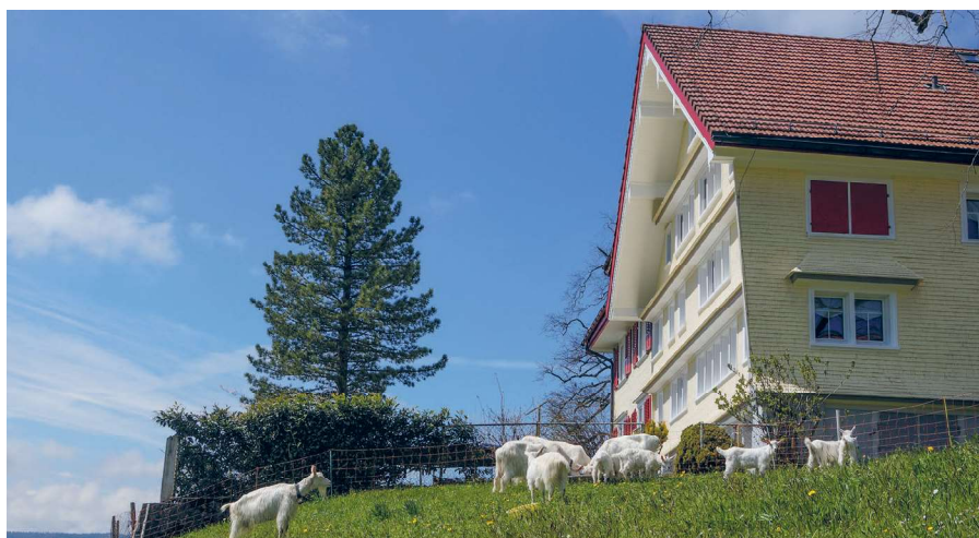
Der Aemisegg-Bauernhof (oben) und die angrenzende Herberge (unten) mit der Alterswohngemeinschaft und den Gästezimmern für Pilger auf dem Jakobsweg.
